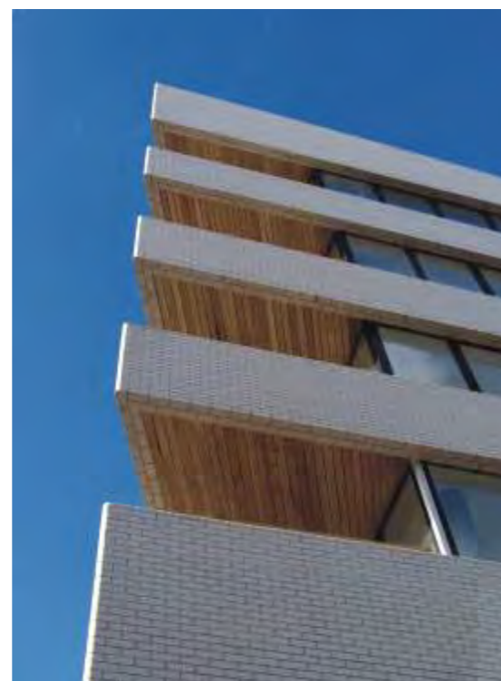
Do wykończenia obydwu skrzydeł zewnętrznych tego kompleksu firma Röben przygotowała według rysunków architektów ponad 8500 sztuk cegieł kształtowych w białym kolorze.
