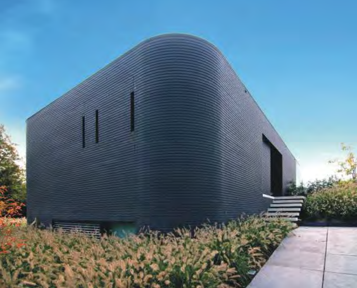
Elewacja w czarnym kolorze, od strony ulicy, otwarta jedynie przez 3 wąskie pionowe otwory. Zamknięty charakter prezentuje także elewacja frontowa.
