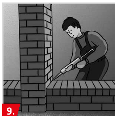
Wypełnianie szczelin np. kitem uszczelniającym
