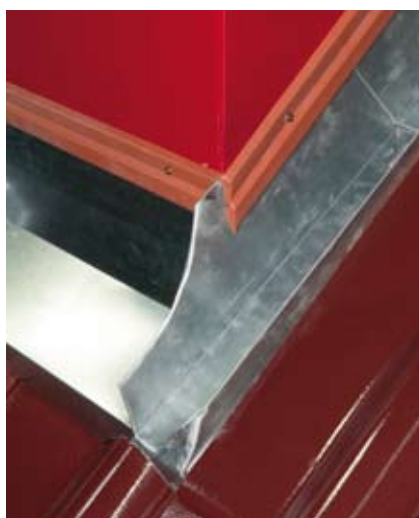
Połączenie na tzw. rąbek stojący
