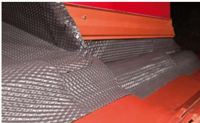
Dokładne wyklejenie obróbki na pokryciu dachowym
