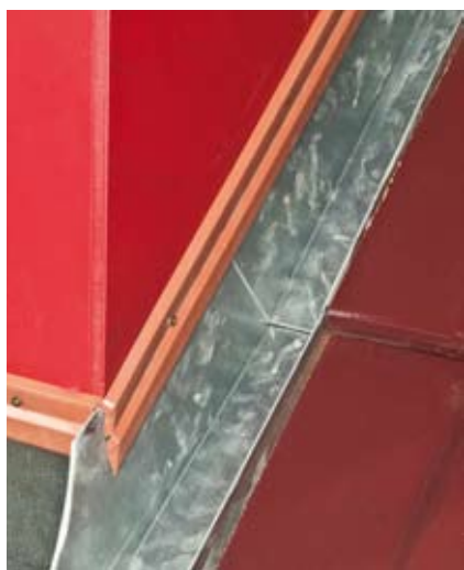
Obróbka pod dachówką
