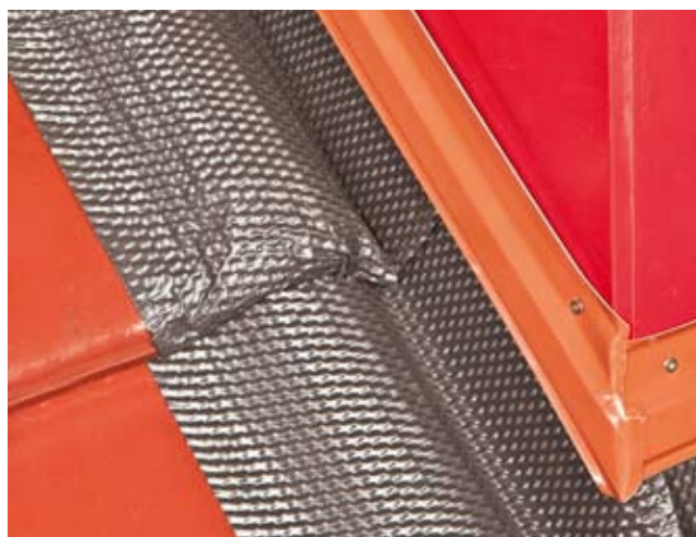
Obróbka miękka na kominie
