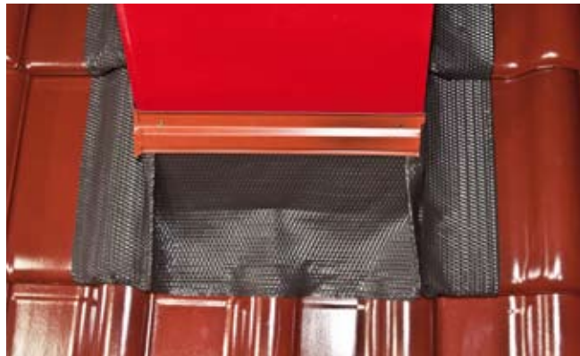
Dokładne wyklejenie obróbki na pokryciu dachowym
