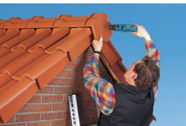
Zakończenie gąsiora kalenicy
