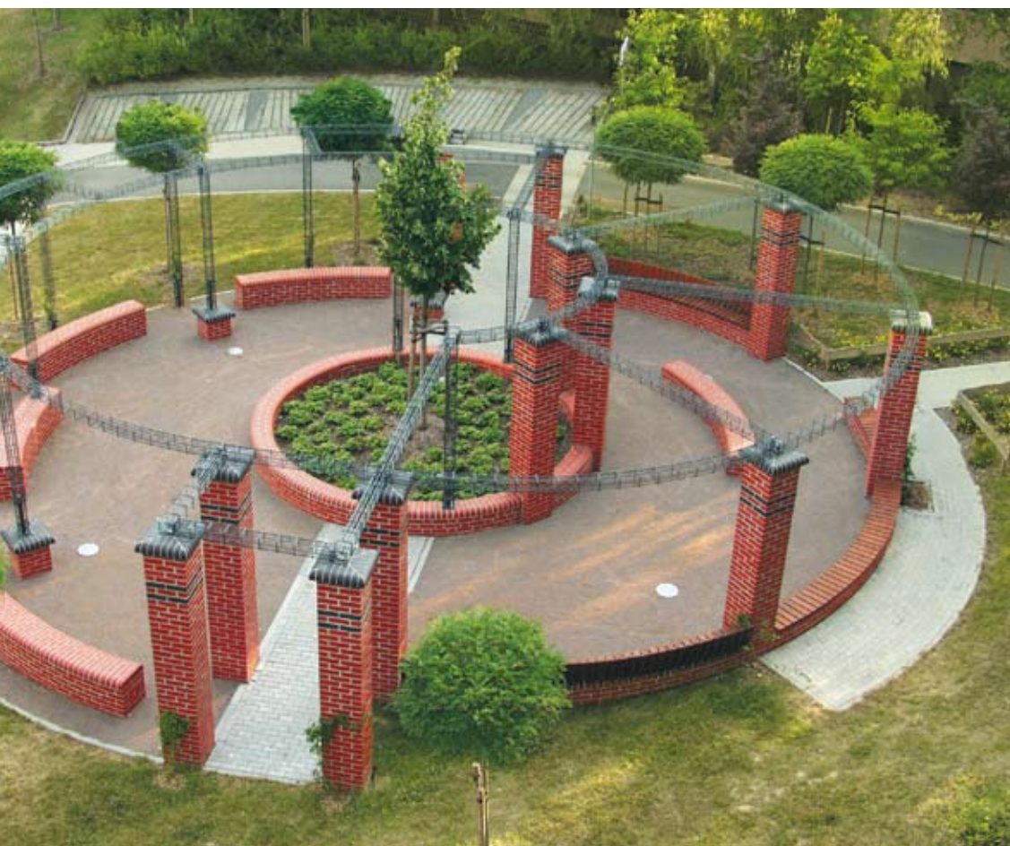
Czyste i precyzyjne przygotowanie, szczególnie widoczne, gdy na ciemnych kapturach na słupki wykonano jasne spoiny.
