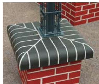
Czyste i precyzyjne przygotowanie, szczególnie widoczne, gdy na ciemnych kapturach na słupki wykonano jasne spoiny.
