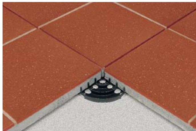
Układanie na specjalnych podkładkach
