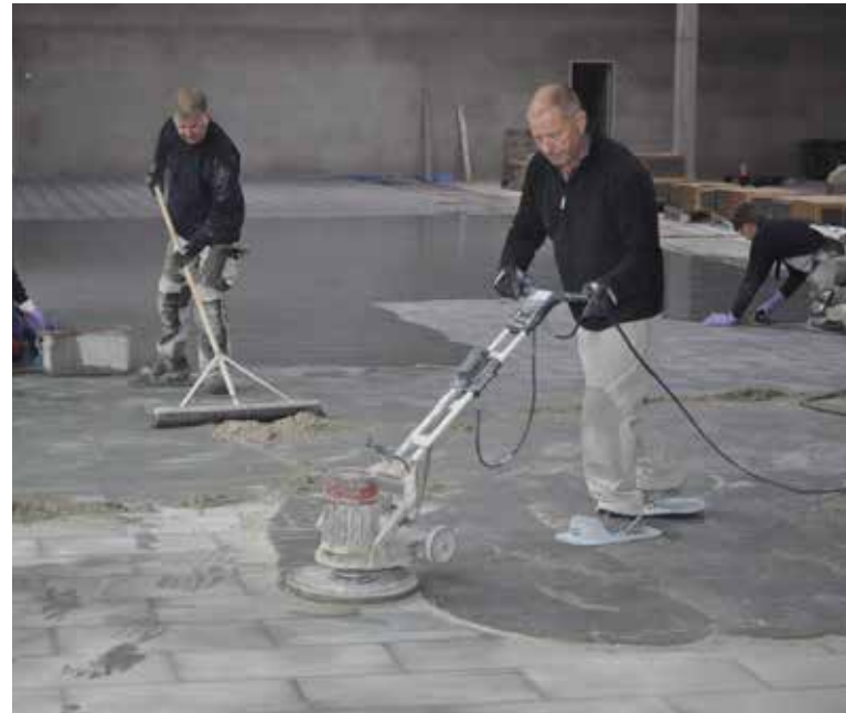
Bardzo wydajne układanie metodą wibracyjną
