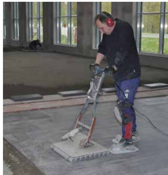
Bardzo wydajne układanie metodą wibracyjną
