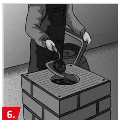
Wypełnianie otworu betonem o konsystencji gęstoplastycznej
