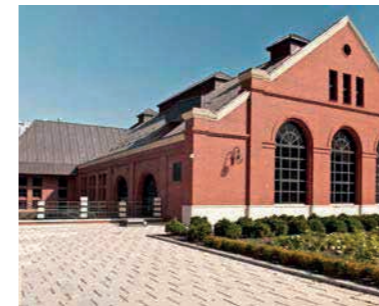
Stacja Ozonowania Wody w Warszawie s. 12
